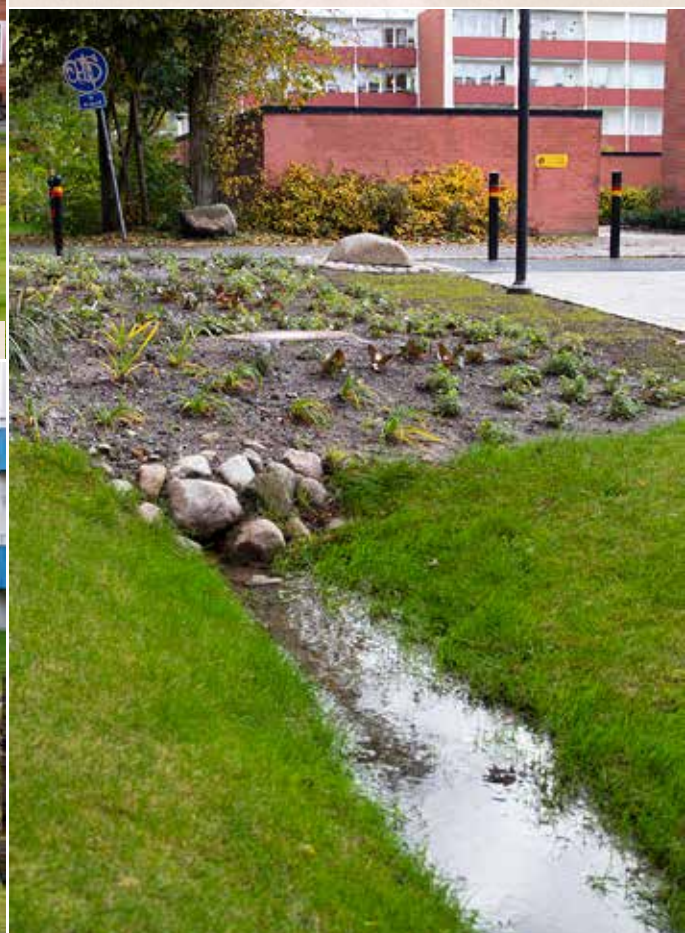
En av de nyplanterade rabatterna. Undertill syns vattnet strömma mot fördröjningsdammen.
