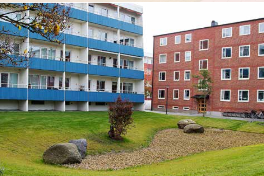
När det inte regnar syns makadamen som ligger i botten på fördröjningsdammen.
