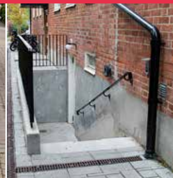
EFTER: Trappan har breddats och vattnet från stuprörets leds via markrännor bort från huset.
