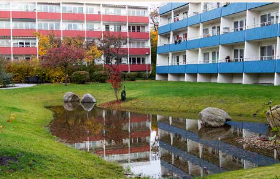
I samband med regn fylls fördröjningsdammen snabbt på med vatten, som sedan i långsam takt leds vidare ut i mark och delvis till kommunens ledningsnät.
