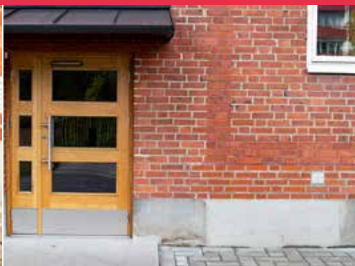
EFTER: Sopskåpet är igenmurat. Dessutom har ytterdörrar, belysning och entrétag bytts ut i samråd med stadsantikvarien då husen är K-märkta.
